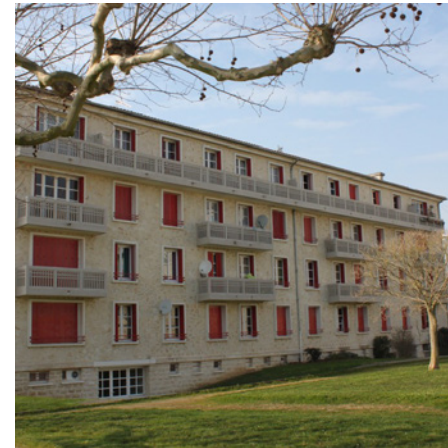
PORT NEUF 6 (1954) - 16 logements
