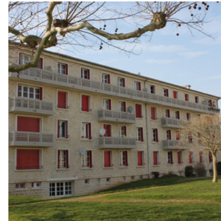
PORT NEUF 6 (1954) - 16 logements
