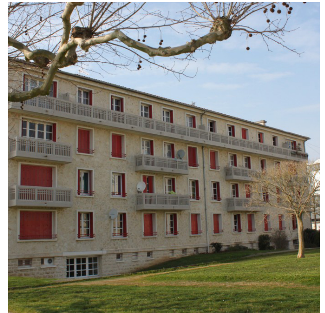
PORT NEUF 6 (1954) - 16 logements
